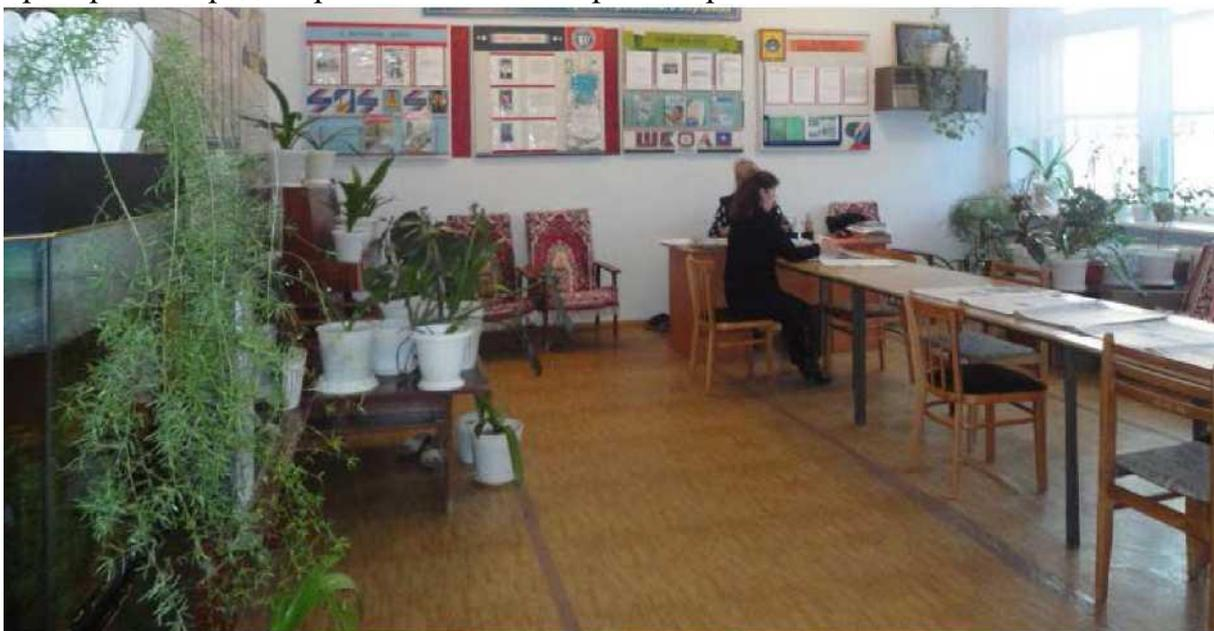
рисунок 15 «Пестрый линолеум уложен неаккуратно, на стыке рулонов использованы опасные металлические набойки».
